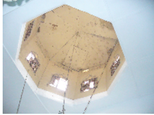
لوحة ١٩ شخشيخة المسجد التي تبرز من سقف البلاطة الوسطي
