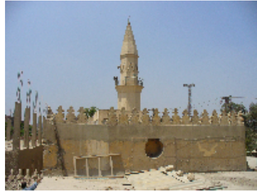
لوحة ٣١ الواجهة الجنوبية من أعلي
