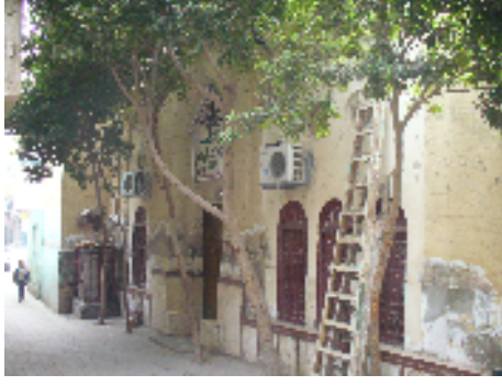
لوحة ٢ تفاصيل للواجهة البحرية
